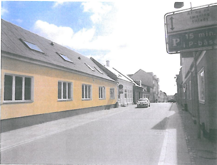
Bygning 1 (facade mod Storegade)
