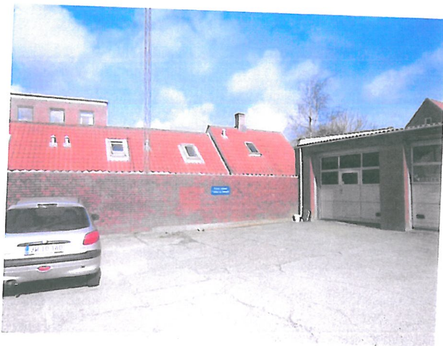
Bygning 3 (til højre med porte)
